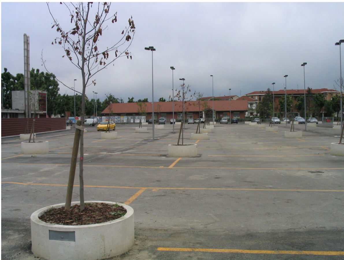
S.Mauro torinese - mercatale (in cantiere)
